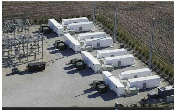
8-rasm: Namunaviy EEST konteyneri (tashqi) 1
