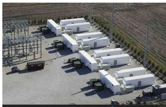
Рис. 8: Типичный контейнер BESS (внешний) 1
