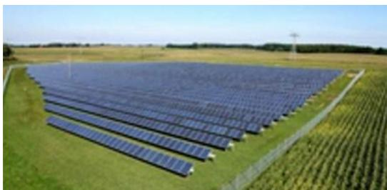
*Рисунок 6: ФЭ система слежения и инверторы (Одноосевые следящие механизмы следуют за солнцем с востока на запад в одной точке. NEXTracker)*
