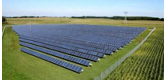
Rasm 7: FE kuzatuv tizimi va invertorlar (Bir o'qli kuzatuvchilar quyoshni sharqdan g'arbga bir nuqtada kuzatib boradi. NEXTracker)
